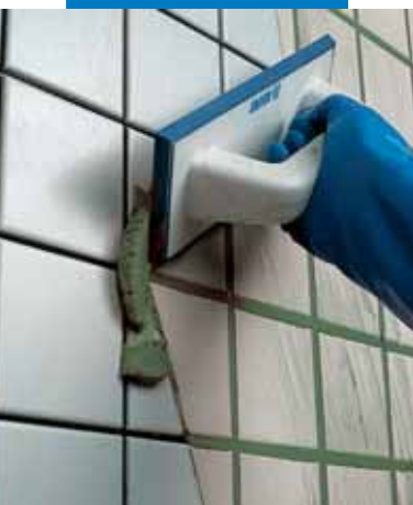
Afvoegen van een wand met Ultracolor Plus met een voegrubber
