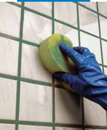
Reinigen en afwerken van wandvoegen met een spons
