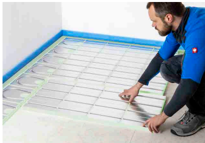
Heizelemente vollflächig auslegen
